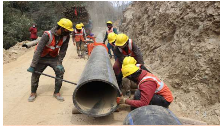
Los trabajadores en Bhután abordan la escasez de agua en Phangyul con la instalación de un sistema de riego por tuberías presurizadas que fue reconvertido con tecnología nueva y resistente al clima. El nuevo sistema de riego beneficiará a 24 pueblos y a más de 1300 acres de tierras agrícolas.
